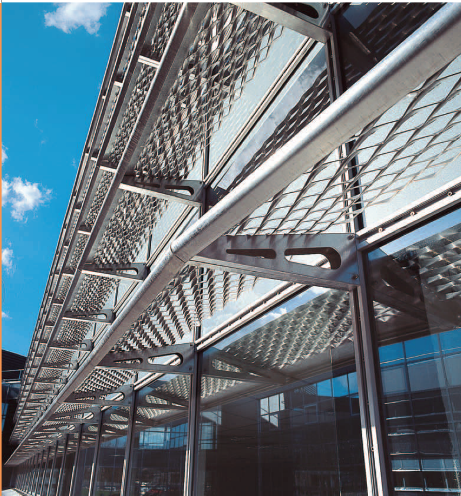
PALAZZINA UFFICI DIREZIONALI - FRANCIA
