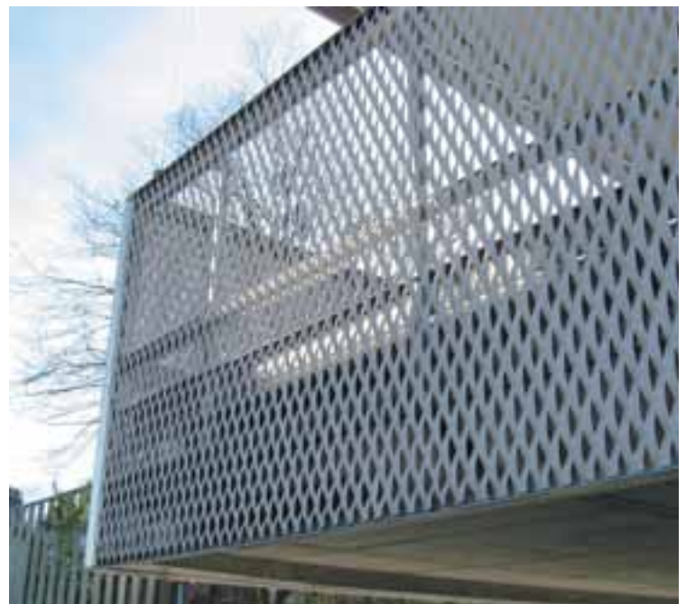
Progetto: Halter Generalunternehmung AG (CH) - Maglia: Ambasciata - DL 110 x DC 40 (52) - av 24 x sp 2 mm Alluminio pallinato - Foto: Metallpfister
