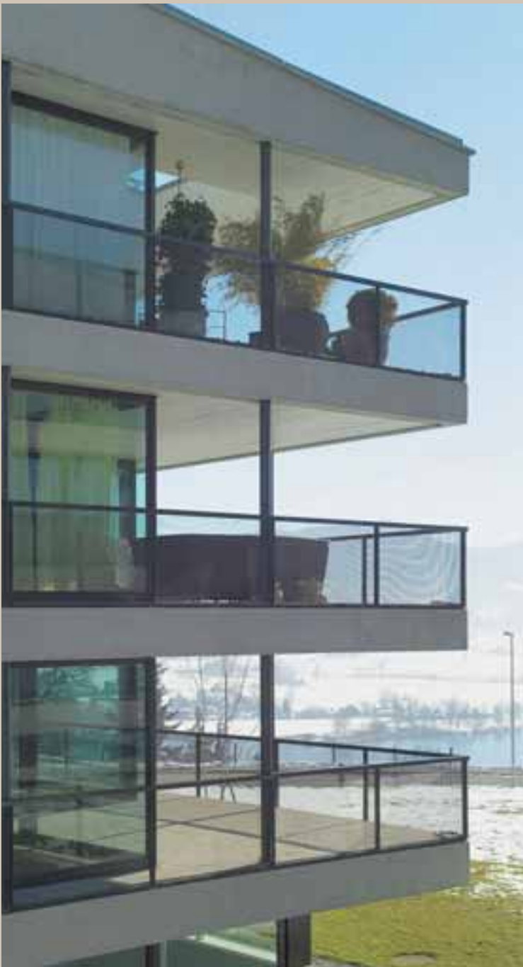
Progetto: Dettli Nussbaumer Architekten GmbH (CH) - Maglia: DL 28 x DC 14 - av 2 x sp 1,5 mm Acciaio al carbonio zincato verniciato - Foto: Huber
