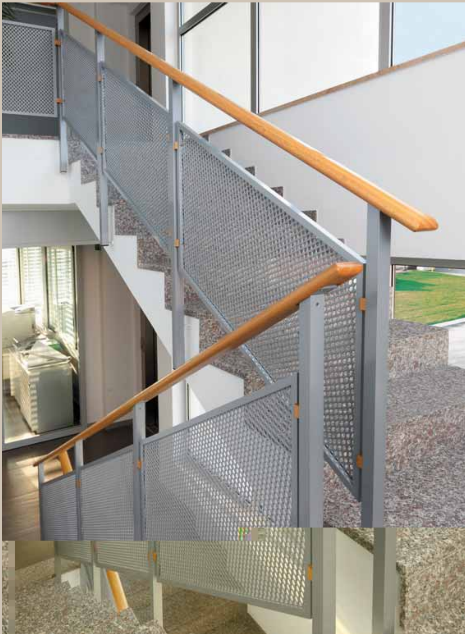
Maglia: ST 25 - DL 25 - av 4,5 x sp 3 - Ø 13 mm - Alluminio verniciato Foto: Studio Diecidodici
