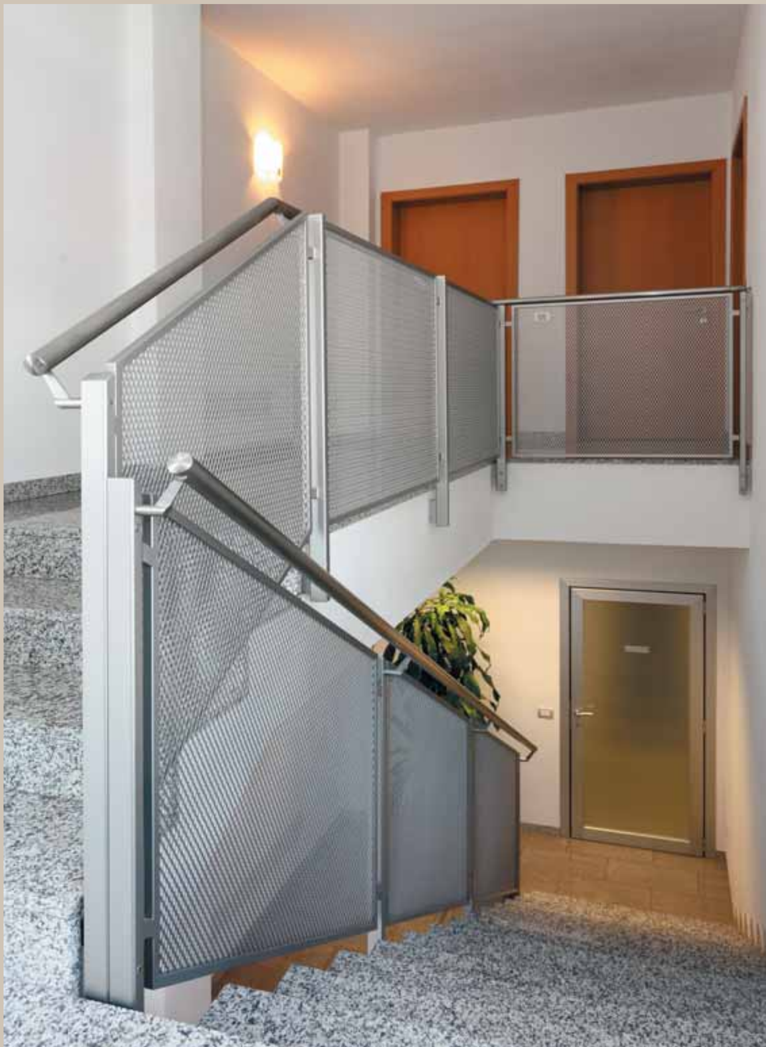
Maglia: DL 14 x DC 16 - av 3 x sp 2 mm - Acciaio al carbonio sendzimir verniciato Foto: Studio Diecidodici
