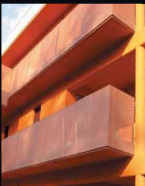
Maglia: DL 16 x DC 8 - av 3 x sp 1,5mm - Acciaio al carbonio sendzimir verniciato
