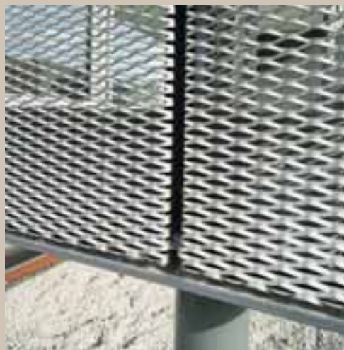
Progetto: Dachtler Partner AG (CH) - Maglia: Fils 5 - DL 62,5 x DC 20 (20) - av 7,5 x sp 1,5 mm Alluminio naturale - Foto: Huber
