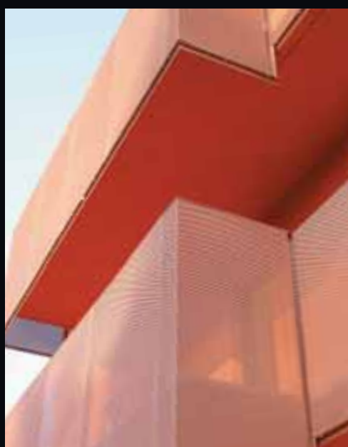
Maglia: DL 16 x DC 8 - av 3 x sp 1,5mm - Acciaio al carbonio sendzimir verniciato
