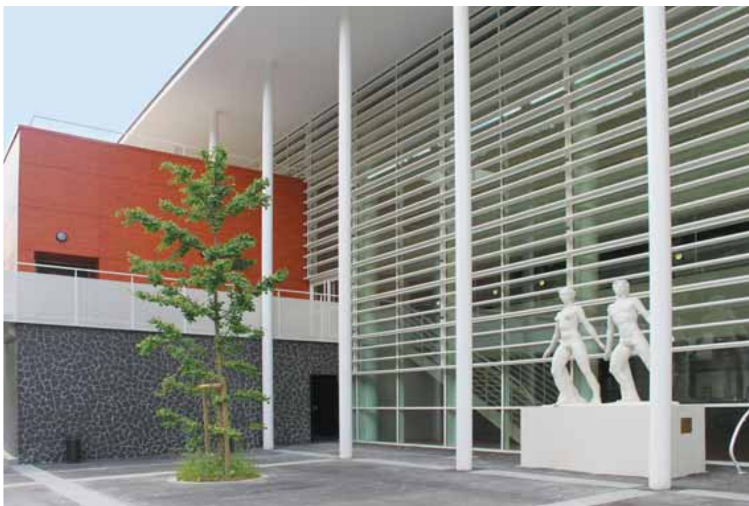
Progetto: Arch. M. Hesters (F) - Maglia: Academy - DL 115 x DC 40 (48) - av 20 x sp 1,5 mm Acciaio al carbonio zincato verniciato
