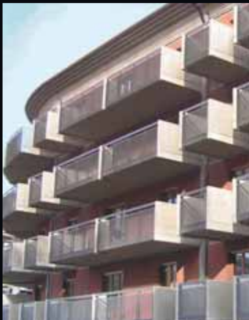
Maglia: Fils 21 - Acciaio al carbonio zincato a caldo
