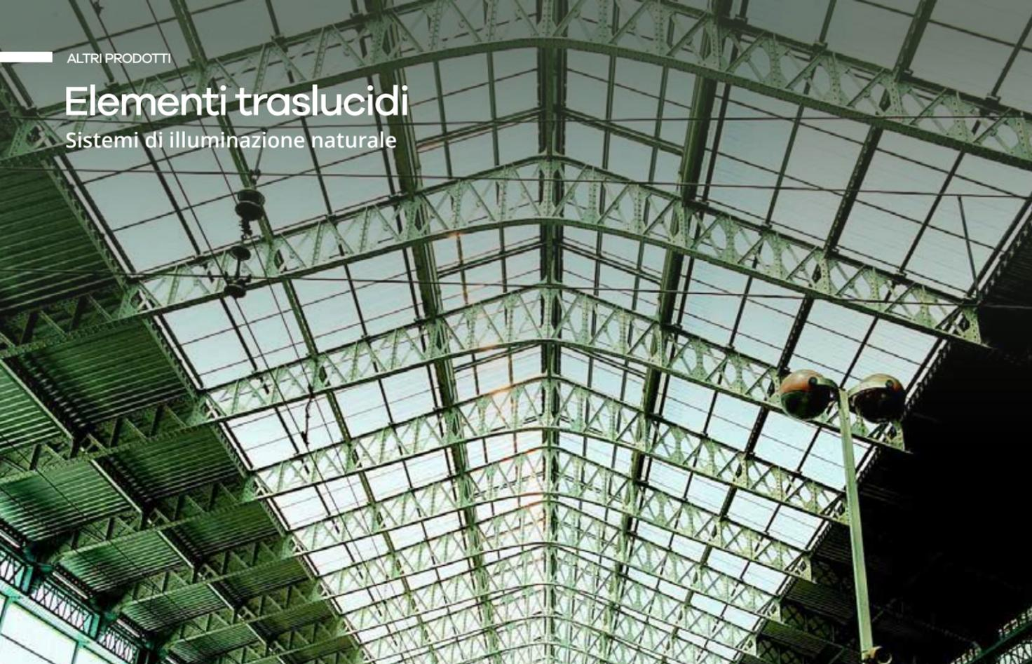
Per le zone di illuminazione naturale sono disponibili tre versioni di lastre traslucide aventi gli stessi profili delle lastre di copertura Ondulit Coverib.
